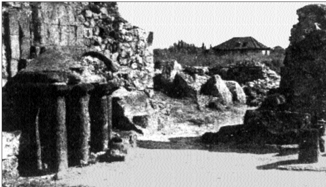
Hypocaustum (padló alatti fűtés) oszlopok a nagy fürdőben, a falon üreges téglák sora
